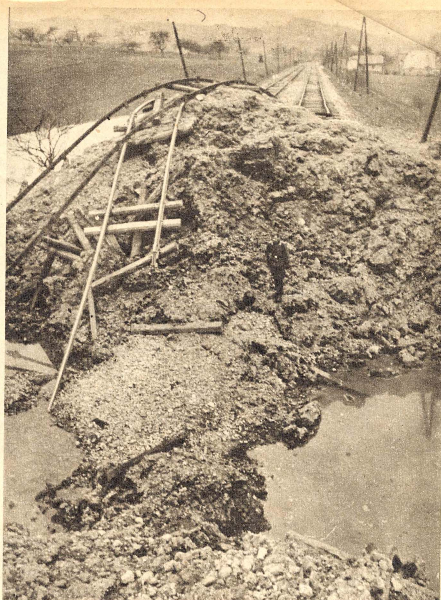
M aßarbeit deutscher Stukas. Diese strategisch wichtige zweigleisige Eisenbahnlinie wurde von zwei schweren Bomben vernichtend getroffen. Der Bahndamm ist so auseinandergerissen, daß in den Einschlagtrichtern das Grundwasser hochstieg. Das Luftbild links zeigt den deutschen Vormarsch im nördlichen Serbien. Rechts an der Straße haltende Panzer, die von Kolonnen motorisierter Infanterie überholt werden
